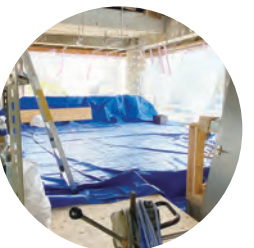
▲現在改装中の2Fの多目的スペース。完成が楽しみです!
